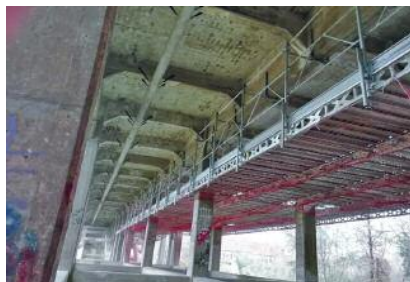
Rafforzamento dei pilastri portanti
