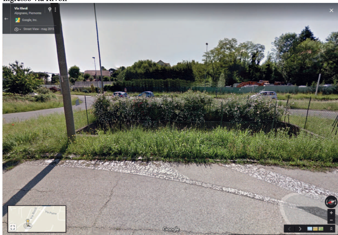
Opere d'arte esistenti (manufatto bealera)
